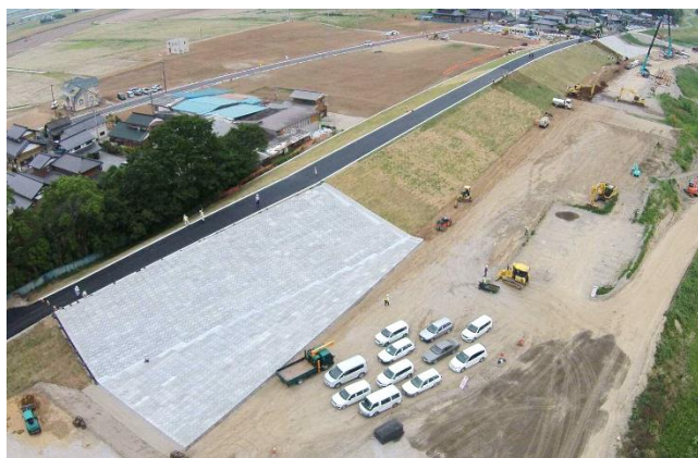
写真：鬼怒川（茨城県常総市）関東・東北豪雨（H27.9）による決壊箇所の本復旧工事完成直前の状況（H28.5） （国土交通省関東地方整備局 提供）
